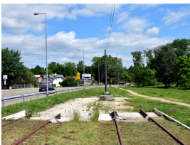
Budowa trasy tramwajowej na WINNICE
