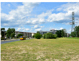
Budowa trasy tramwajowej na NOWODWORY
