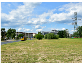
Budowa trasy tramwajowej na NOWODWORY
